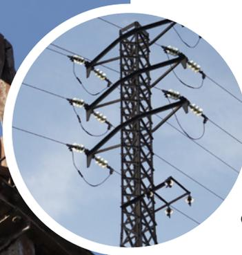
Der Stromschlag des Vogels tritt auf, wenn er mit seinen Füßen oder Flügeln ein Kabel und einen metallischen Teil des Mastes oder zwei verschiedene Kabel berührt. In diesem verhängnisvollen Moment erleidet das Tier sofort einen tödlichen Stromschlag.
